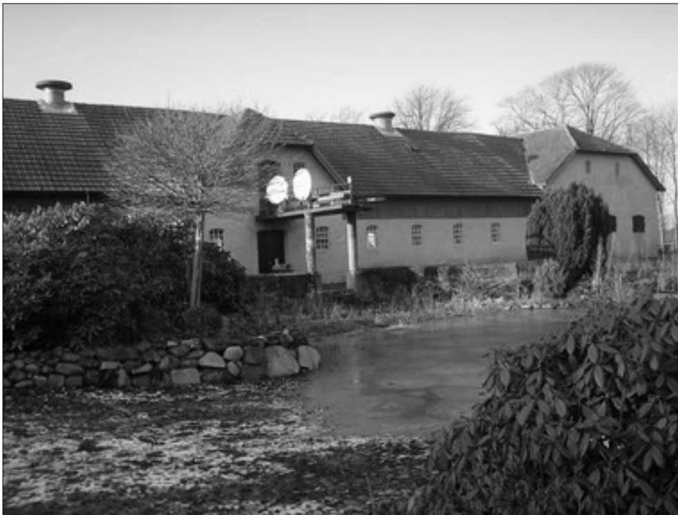
Rønkildegårds møddingsplads. Bemærk broen ud fra grisestalden oven over kostalden.
