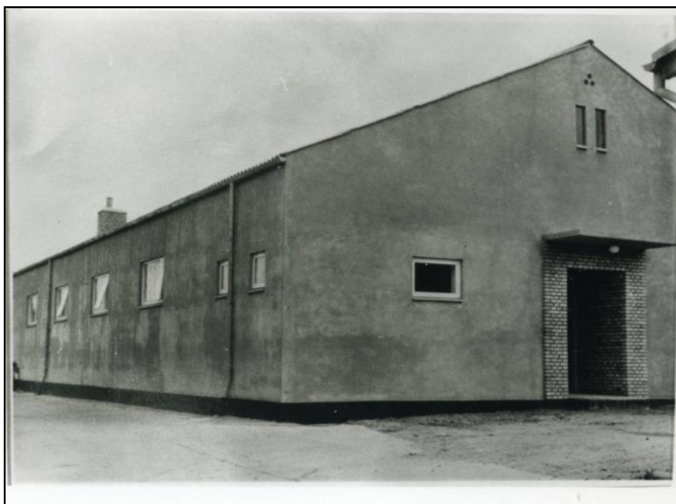
Bording forsamlings- hus, som det så ud efter ombygning i 1956. Indgangsdøren blev flyttet hen midt i gavlen.
